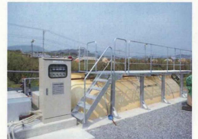
▲田辺市内梅加工場に設置した小規模事業者向け排水処理ユニット
